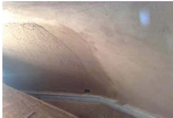
◀ Unterputz: links frischer Spritzauftrag, rechts nach 2 Tagen Standzeit
