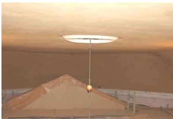
◀ Nach Aufbringung des Oberputzes
